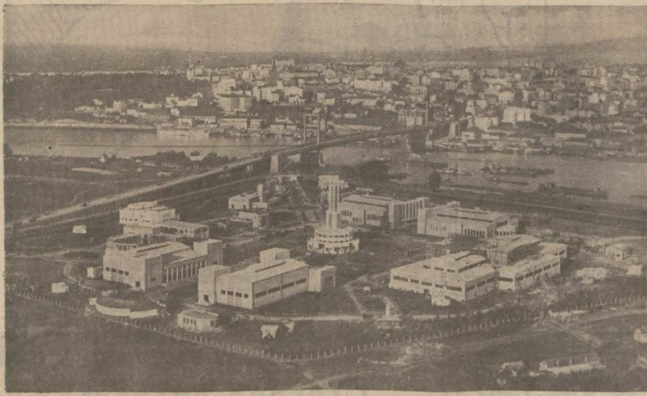
Tunanın Belgradtan görünüşü
